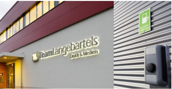
2007 in Hamburg fertiggestellter Neubau, mit diversen nachhaltigen Assets, u. a. mit Ladestationen für E-Fahrzeuge und großen Photovoltaik-Anlagen auf den Dächern.
